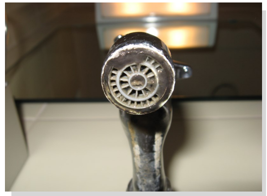
Stark verschmutzte Strahlregler (Bildquelle: Gesundheitsamt Region Kassel)
